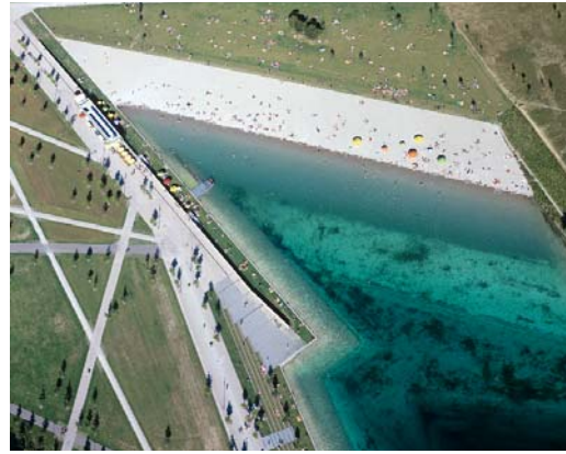
Badestrand und Ausschnitt Kaianlagen mit Servicestation
